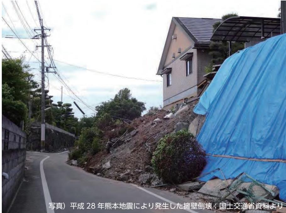
写真) 平成 28 年熊本地震により発生した擁壁倒壊；国土交通省資料より
